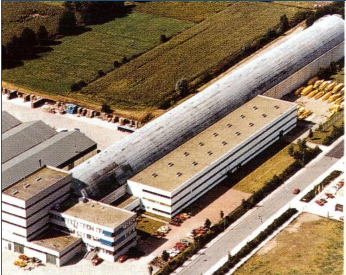
Fig.24. De Vacuüm tank. De lengte van de tank is ca. 200m.
