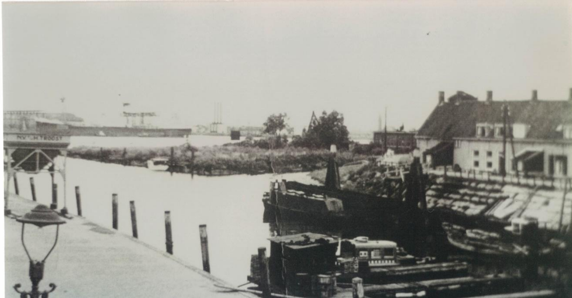
Figure 6 1952 Zicht op de haven en de Maas
