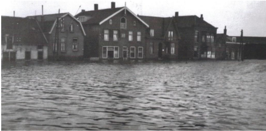
Figuur 17. Springtij 1948. De Nieuwedijk ter hoogte van de havenmonding.
