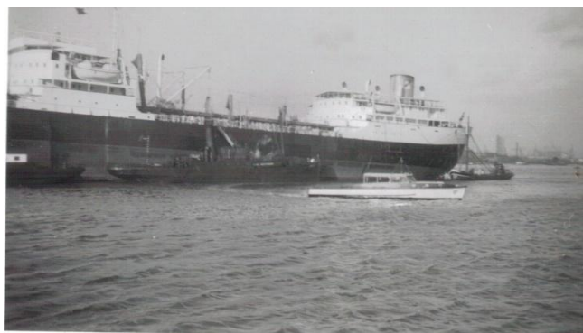
Figuur 21. Zicht op de Maas
