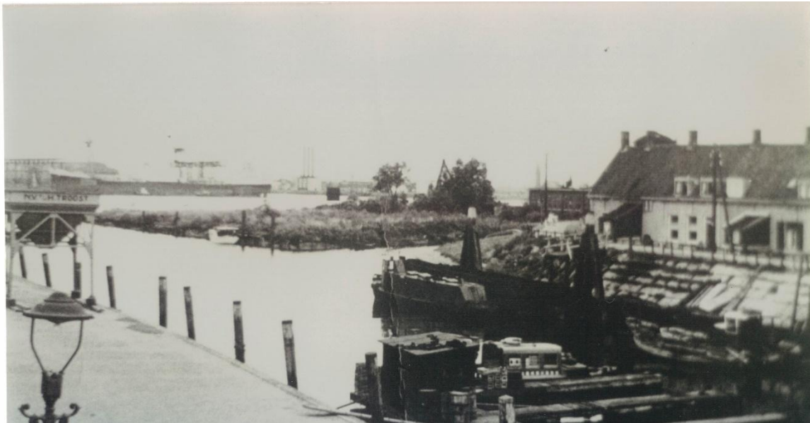
Figure 6 1952 Zicht op de haven en de Maas
